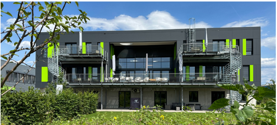
Hauptstandort der Solectrix GmbH in Fürth. © Solectrix
